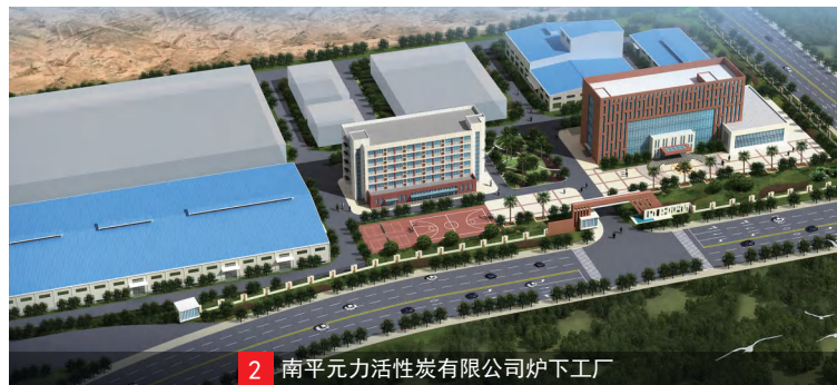
2 南平元力活性炭有限公司炉下工厂 NANPING YUANLI ACTIVE CARBON COMPANY-LX FACTORY
